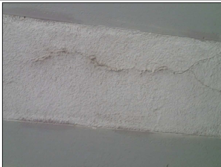
Foto č. 1 – konstrukce K 01 – nad O 01 – průsak pojiva, trhliny
