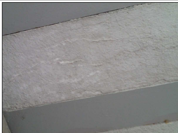
Foto č. 2 – konstrukce K 02 – nad O 01 – průsak pojiva, trhliny
